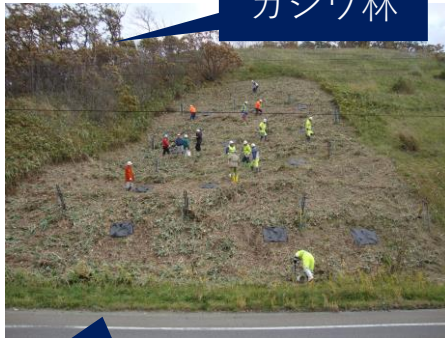
斜面の植栽試験状況
